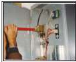
Detalle del sistema de actuación por abrefreno
