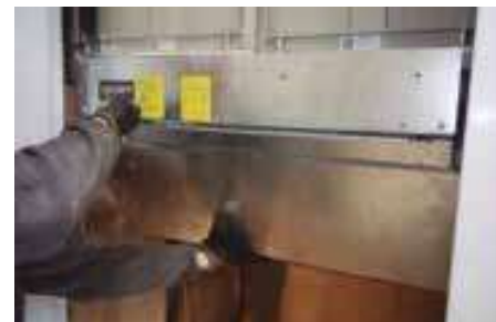
Detalle del faldón telescópico bloqueado abatible
