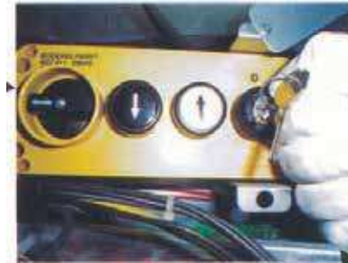
Sistema de rescate de emergencia para movimiento de la cabina
