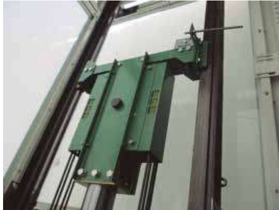
Cabezal hidráulico y cables de tracción
