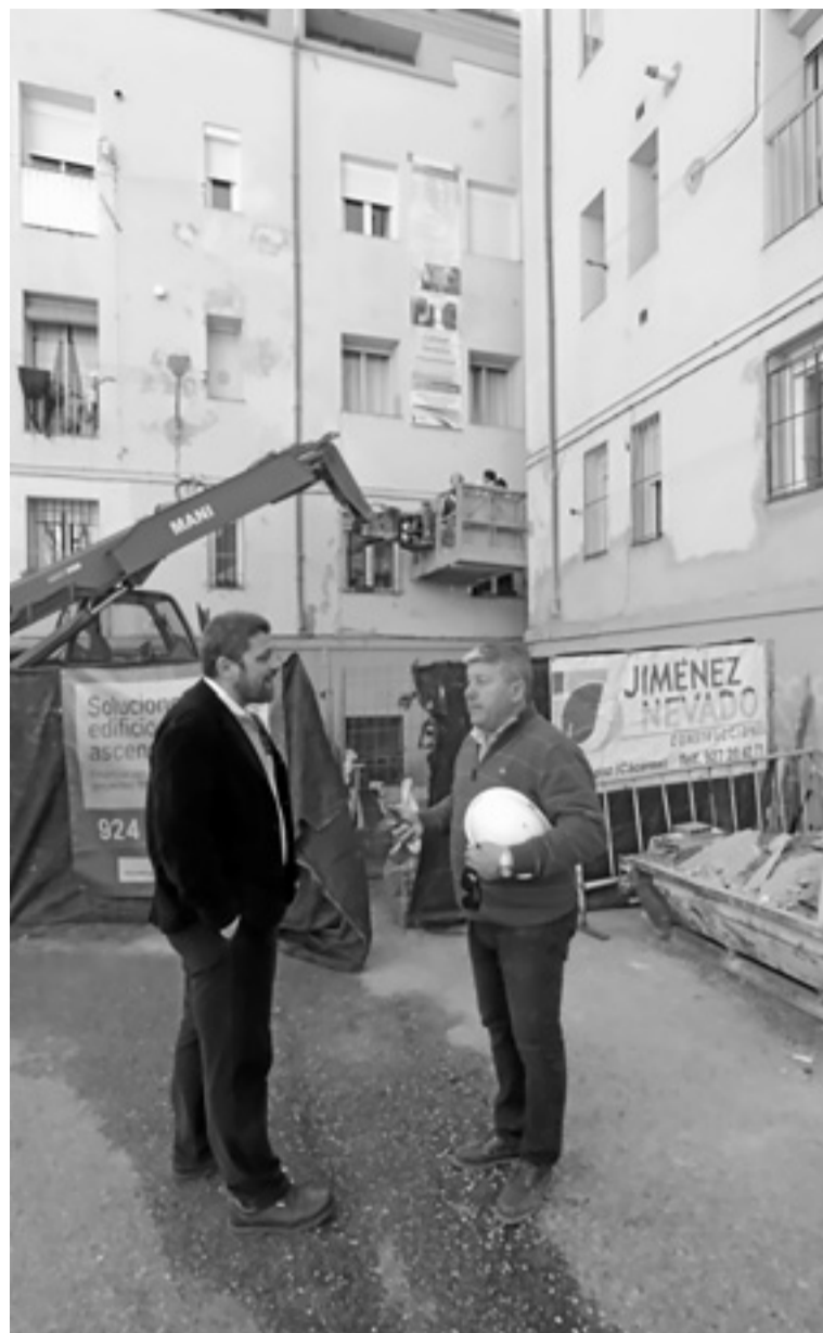
Obras de instalación de un ascensor en Ronda del Carmen. :: L. CORDERO
